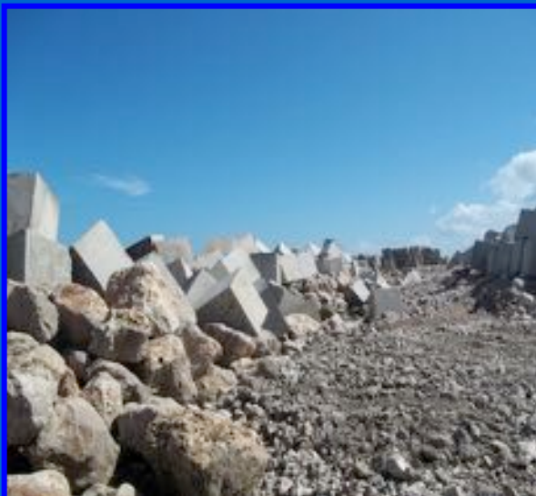
ESTRUCTURA DE PROTECCION, LADO
