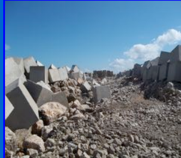
ESTRUCTURA DE PROTECCION, LADO ESTE
