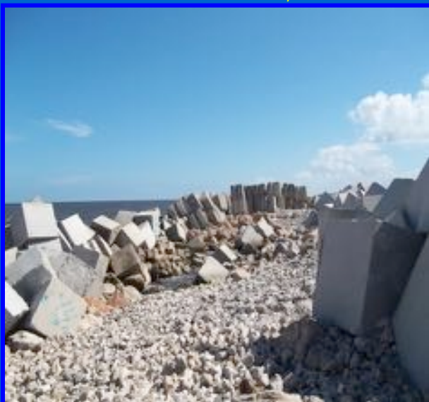
ESTRUCTURA DE PROTECCION LADO ESTE
