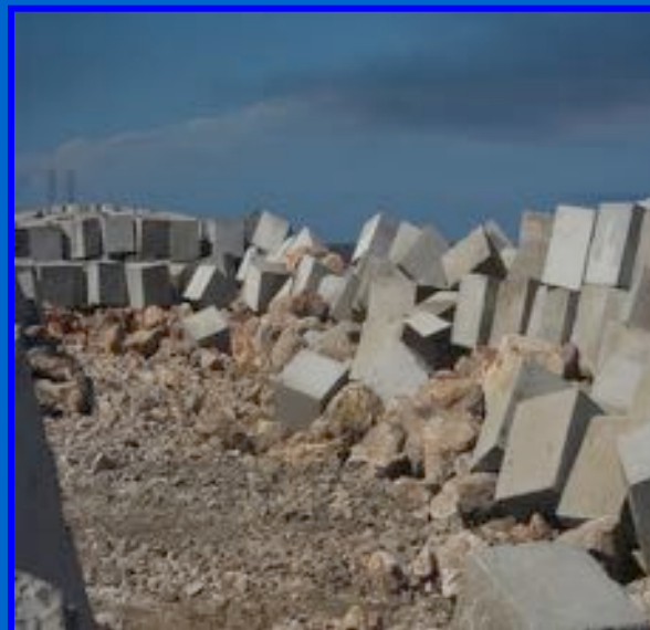
ESTRUCTURA DE PROTECCION, LADO OESTE
