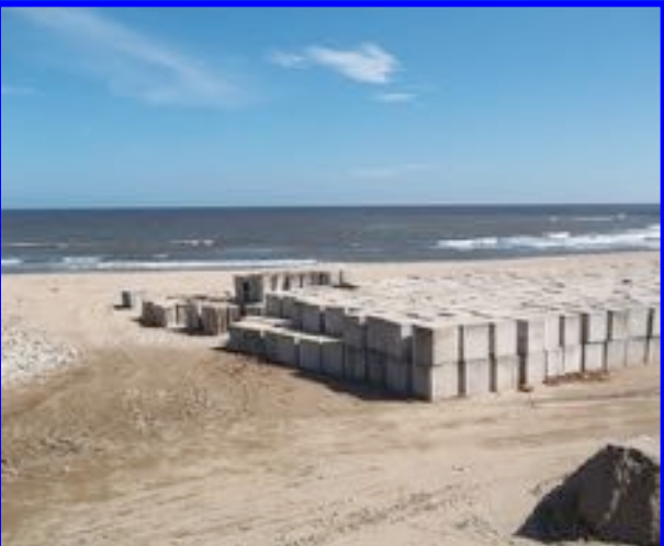
ALMACEN, CUBOS DE 3.7, 5.6 TON. Y BASE DEL MASTIL
