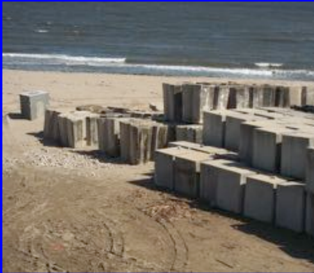
BASE DEL MASTIL, CUBOS DE 5.6 Y 3.7 TON
