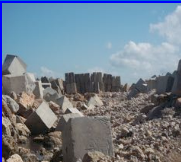
ESTRUCTURA DE PROTECCION, LADO ESTE
