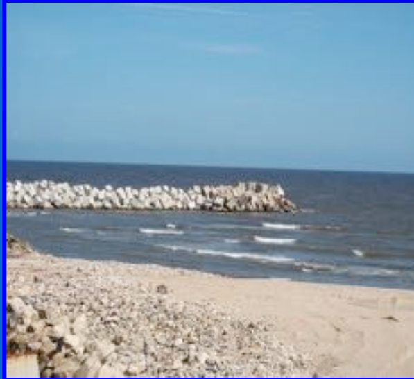
AREA DE QUEMADORES, ESTRUCTURA DE PROTECCION
