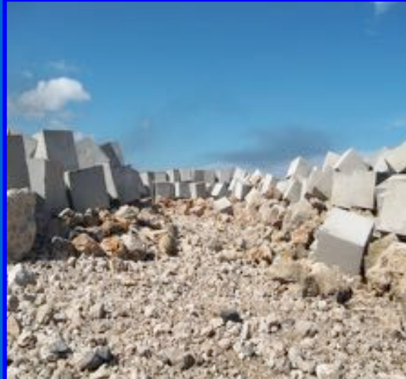
ESTRUCTURA DE PROTECCION, LADO OESTE
